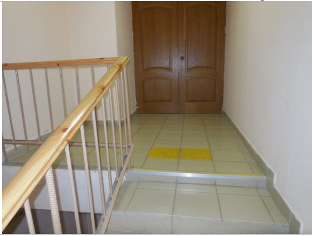
Фото №19 – Пути движения внутри здания (лестница).
