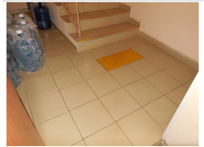
Фото №16 – Пути движения внутри здания (лестница).
