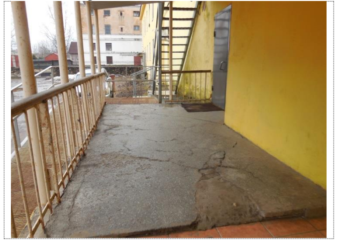
Фото №8 – Входная площадка.
