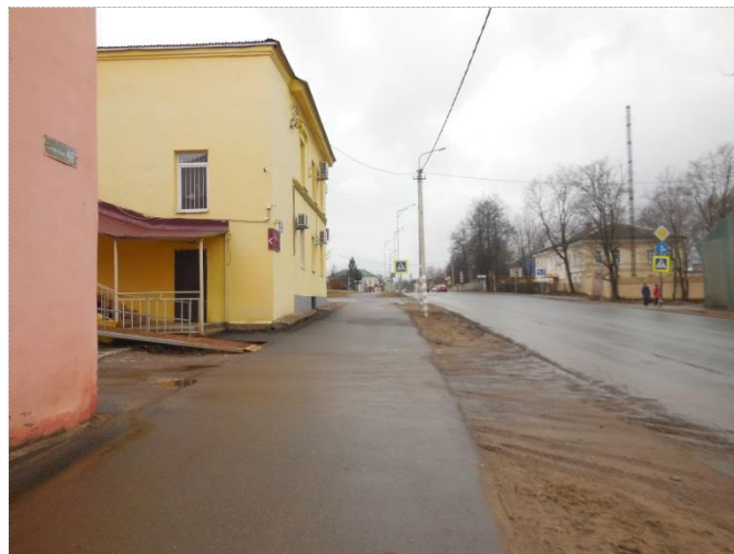
Фото №2 – Подходы к объекту
