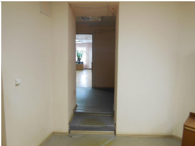
Фото № 23 – Пути движения внутри здания (двери).
