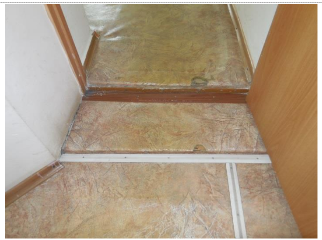
Фото № 24 – Пути движения внутри здания (двери).
