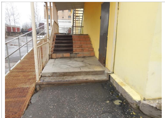
Фото №5 – Наружная лестница.
