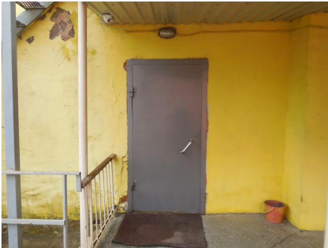
Фото №9 – Входная дверь (внешняя).
