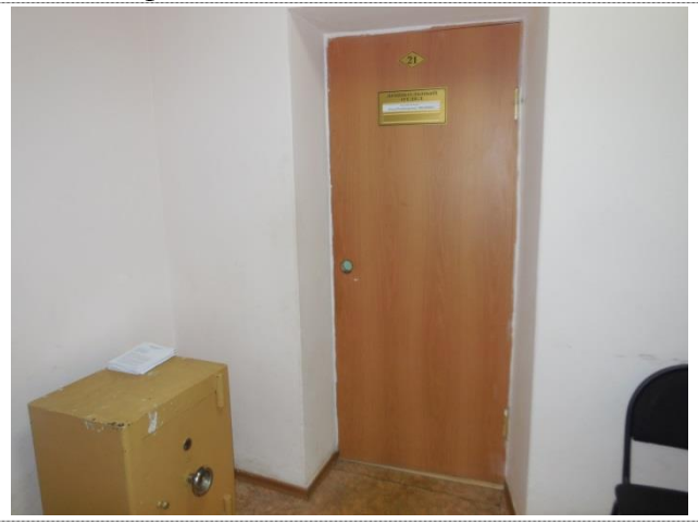
Фото № 20 – Пути движения внутри здания (двери).
