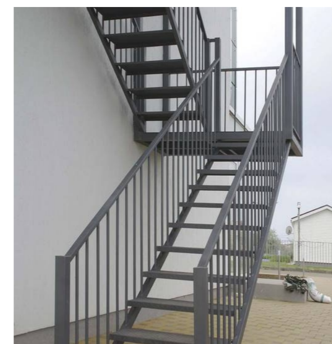
Аналоги конструкции сварной лестницы
